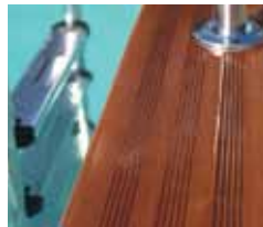
Escadas interiores em aço inoxidável
