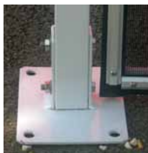
Fixação posterior de porta
